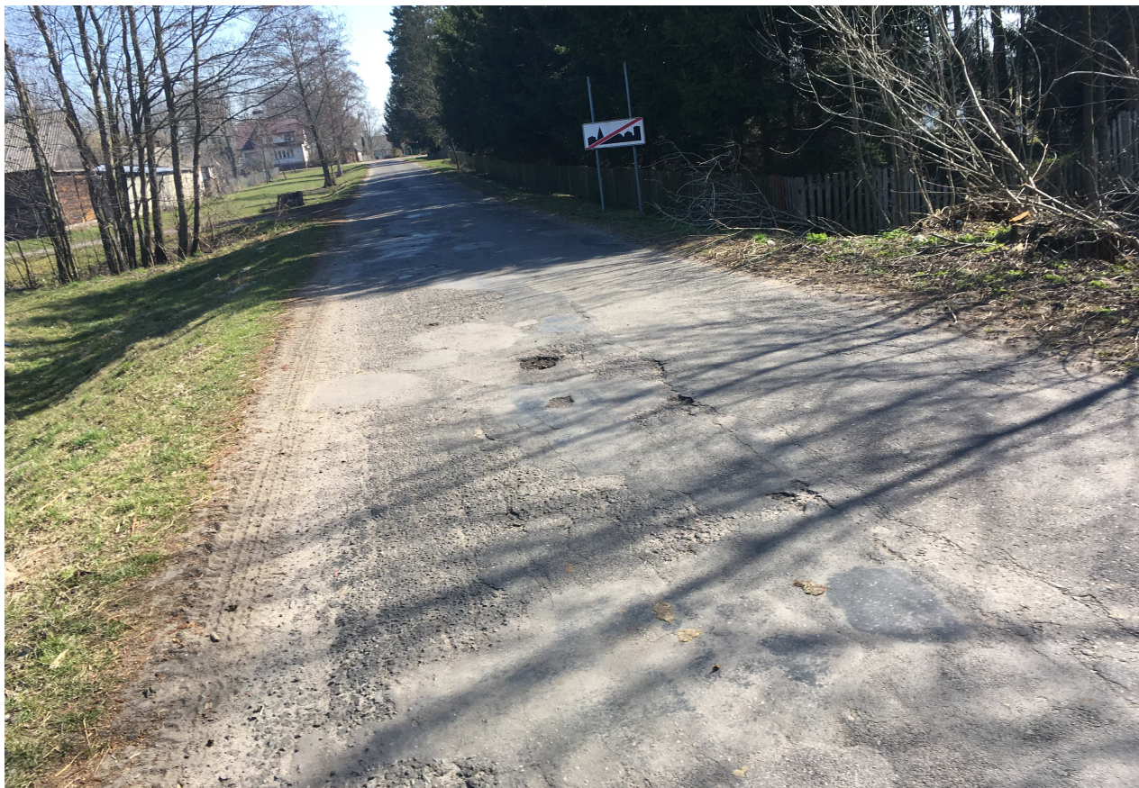
Fot. 2. Widok nawierzchni w km 0+300, spękania siatkowe i wykruszenia
