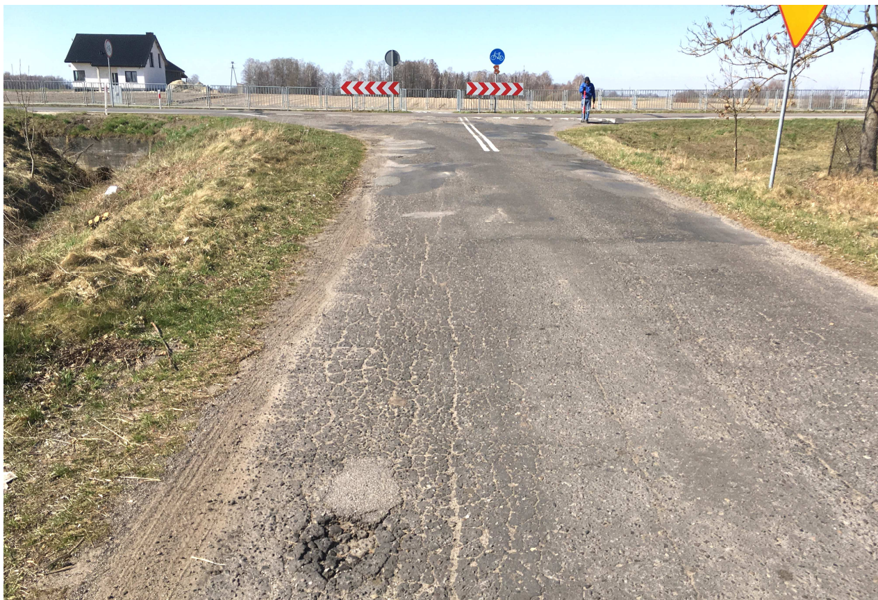
Fot. 1. Widok w kierunku drogi wojewódzkiej, spękania siatkowe i ubytki
