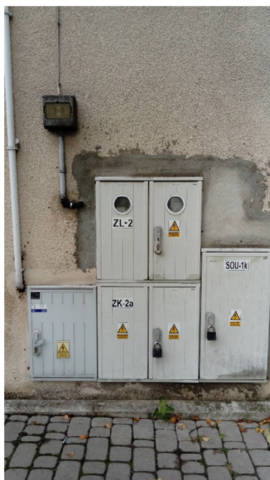
Widok złączy kablowo-licznikowych
