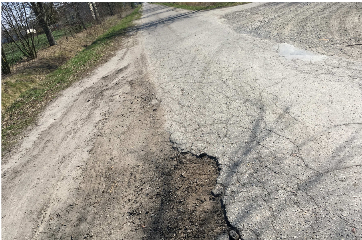
Fot. 1. Widok w km 0+120,0, spękania siatkowe i ubytki
