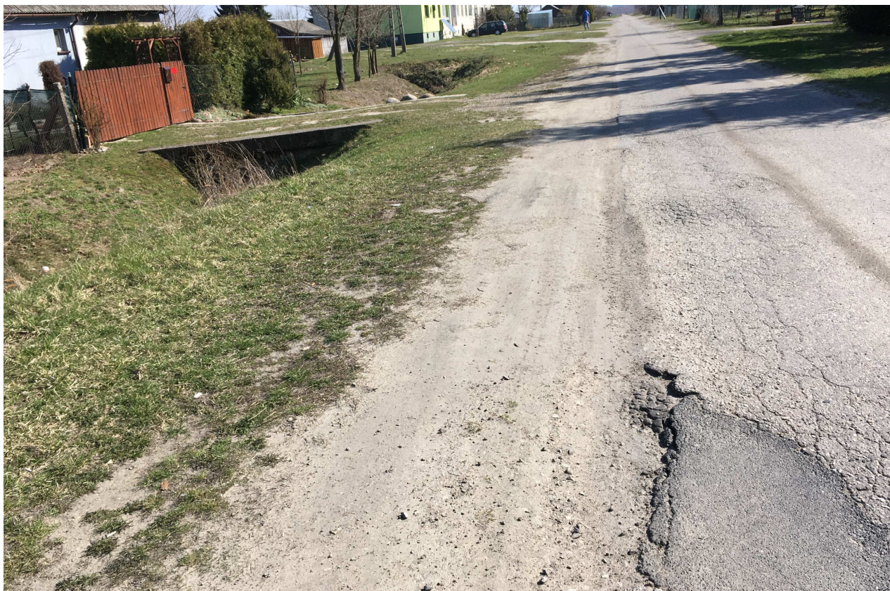
Fot. 2. Widok nawierzchni w km 0+400, strona po której zaprojektowano poszerzenie nawierzchni
